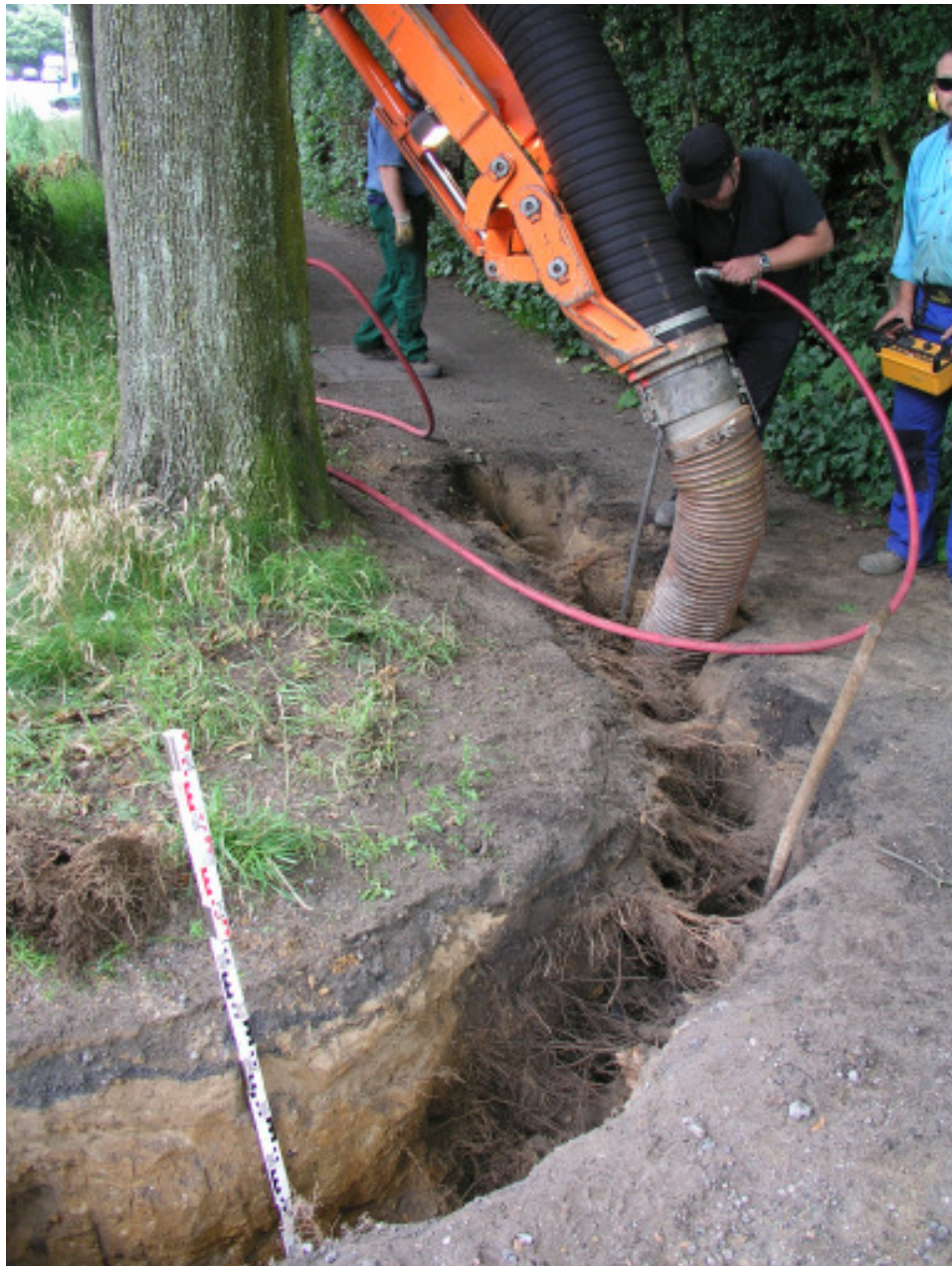
Abb. 19: Im Gehwegbereich gab es viele, oberflächennahe Wurzeln (Standort 4)
