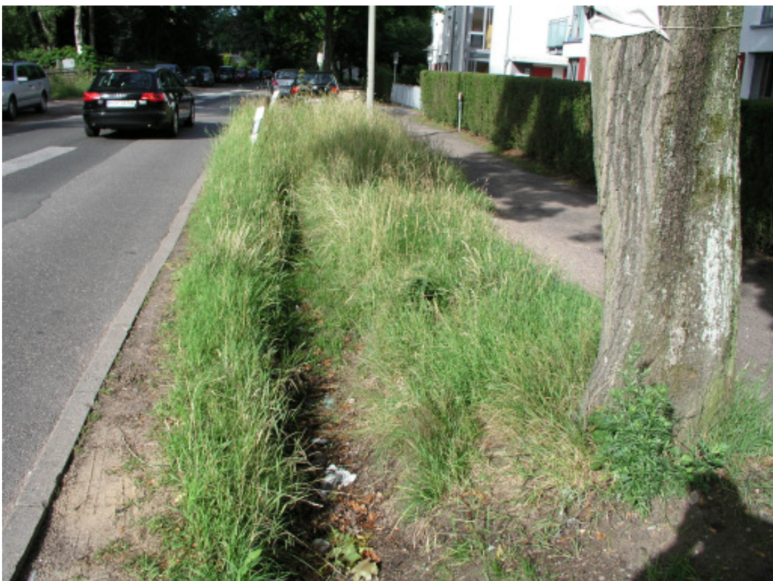
Abb. 6: Die Situation auf der nördlichen Seite der Emil-Andresen-Straße: Neben dem Tiefbord gibt es einen ca. 2,80 m breiten Grünstreifen; zuerst ein ca. 0,70 m waagerechter Streifen, dann ein ca. 0,70 m breiter Graben und daran anschließend ein mitGras bewachsener, ca. 1,40 m breiter Streifen, in dem die Bäume mittig stehen; der Gehweg mit Wasser gebundener Decke ist ca. 2,20 breit
