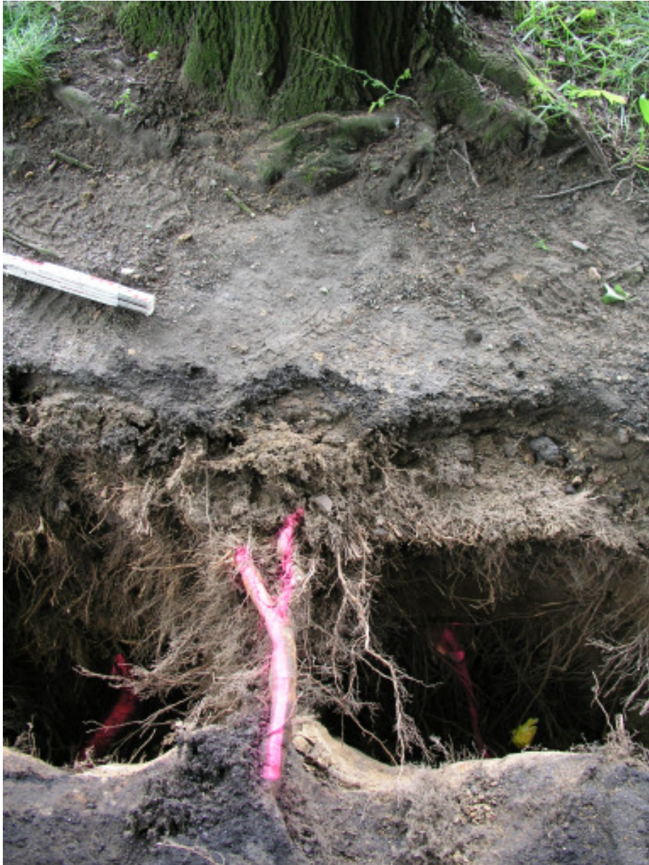
Abb. 21: In ca. 50 – 60 cm Tiefe gab es einen zweiten Wurzelhorizont (Standort 4)
