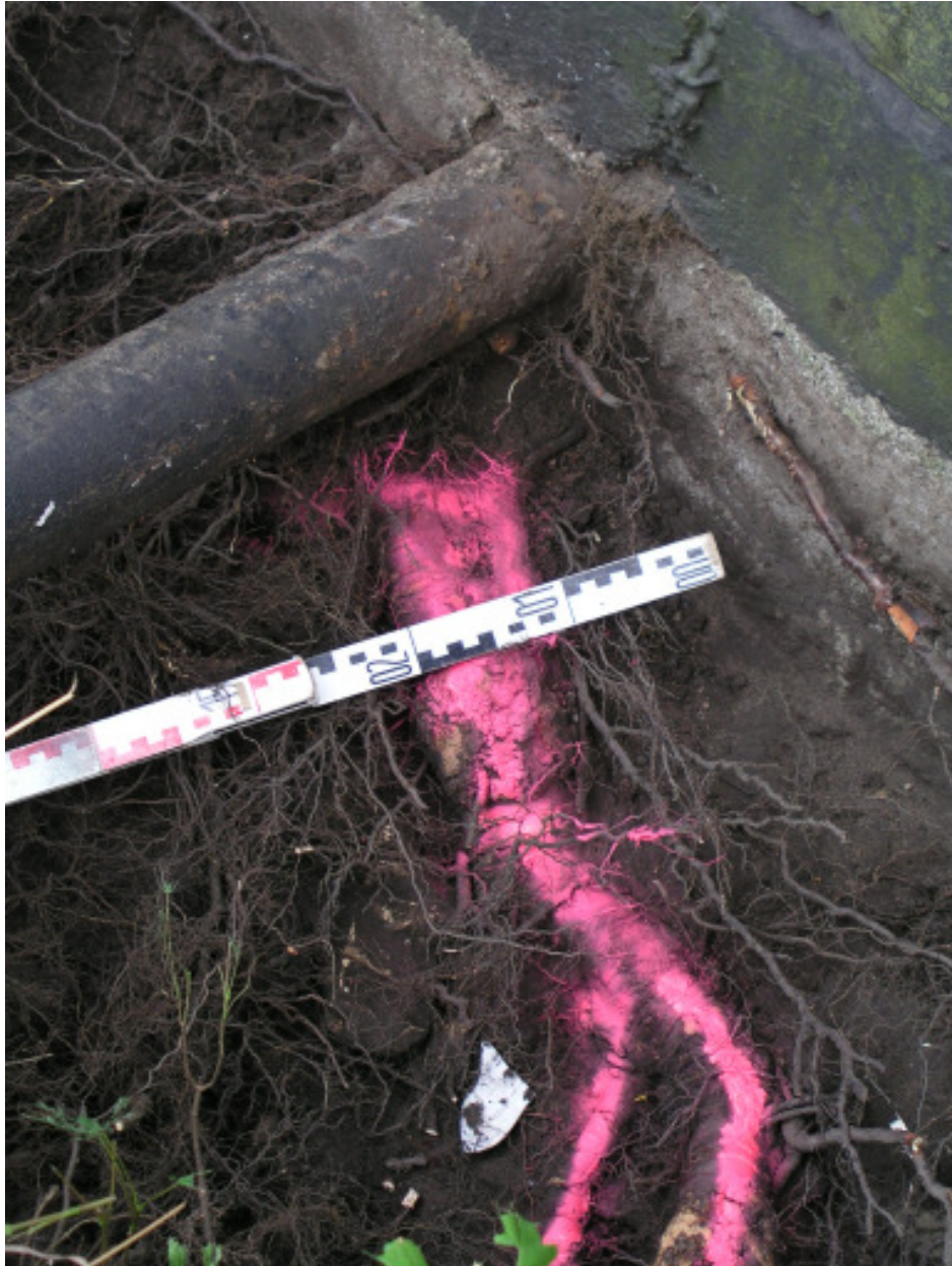
Abb. 16: Bei der zweiten Birke war auch eine Wurzel mit 10 cm Durchmesser im Graben vorhanden
